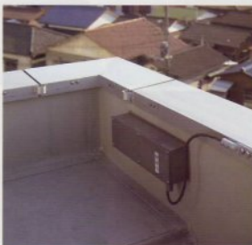
避雷笠木(むね上げ導体システム)
