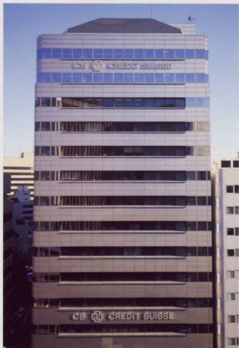
赤坂一丁目共同ビル タワースパンドレル
